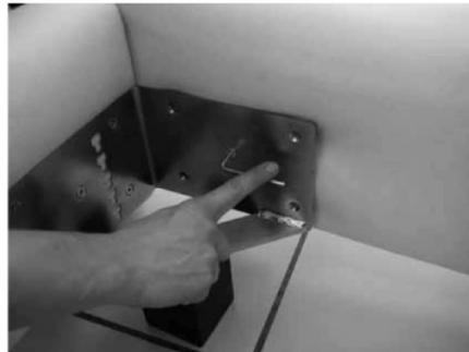
**6.** Befestigen Sie jetzt das Fußteil mittels der Verbinderwinkel an den Seitenwangen. Befestigen Sie den Winkel auf einer Seite zunächst locker in der Mittelbohrung und montieren Sie dann die andere Seite . Jetzt können Sie alle Schrauben befestigen.
